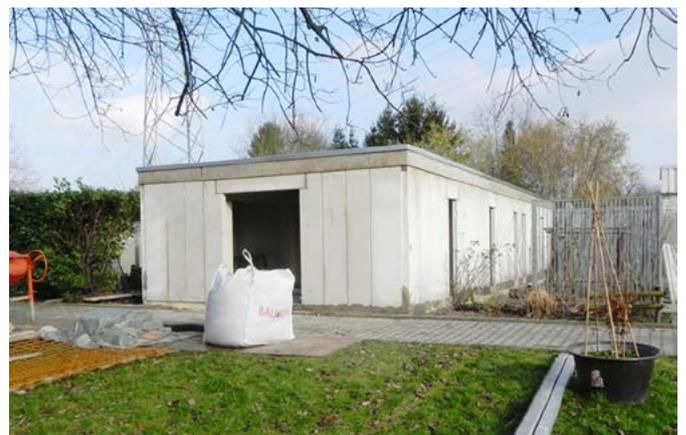
Zudem sanierten wir 2021 unsere Kleintierquarantäne. Hier war das Dach undicht, es bestand Verletzungsgefahr für Mensch und Tier durch abgesplitterte Fliesen, die einzelnen Gehege lösten sich langsam in ihre Bestandteile auf. Alles wurde rausgerissen, neue Gehege gebaut, Wände und Boden neu gefliest, ein Dachfenster eingebaut, das Dach neu eingedeckt und eine Photovoltaikanlage montiert.
